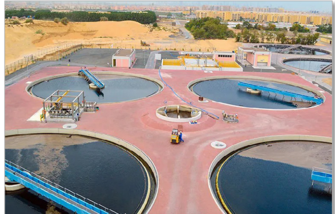
Al Aweer (Warsan) STP (UAE)
